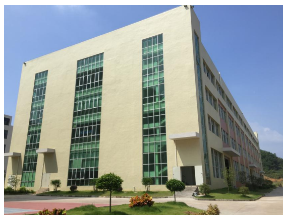
厂房A(生产车间)
